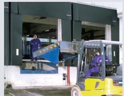
Oude docklevellers uitbouwen, eventueel put aanpassen (bijvoorbeeld met montageplaten of consoles)
